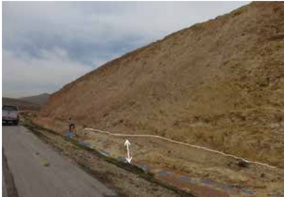
شکل ۱۳: نمایی از گذر آب در حاشیه‌ی جاده‌ی زیبا شهر به خرامه که گویای حرکت روان‌آب به ارتفاع بیش از یک متر است (دید به غرب).
