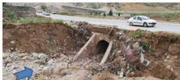
شکل ۲۰: نمایی از اولین پل مسیل سعدی که ورودی روان‌آب به محله‌ی سعدی است که به علت کوچک بودن ابعاد پل، سیلاب سرریز کرده و جاده‌ی ورودی شمالی سعدی را مسدود کرده است. (جهت جریان با پیکان نمایش داده شده است) (دید به جنوب غرب).
