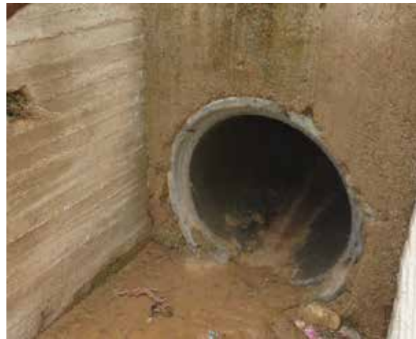
شکل ۷: نمایی از لوله‌ی سیمانی با قطر یک متر برای خروج سیلاب دروازه‌ی قرآن
