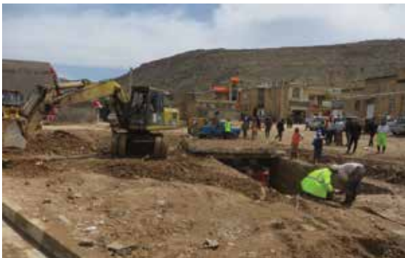
شکل ۱۹: نمایی از کانال زیرزمینی مسیل در محله‌ی سعدی، این کانال توان عبور سیلاب سعدی را نداشته و از این محل سیلاب سرریز و در بلوار شهید وفایی جاری و همچنین، محله‌ی سعدی را زیر آب برده است.
