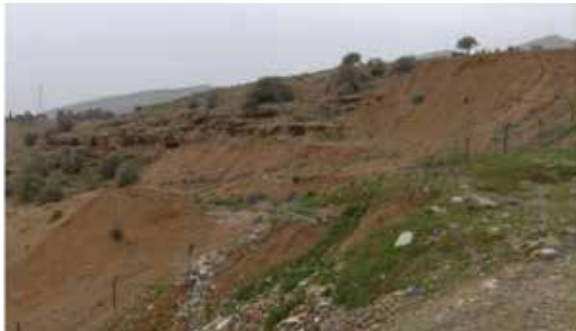
تخلیه‌ی خاک‌های جاده‌سازی در مسیرها
